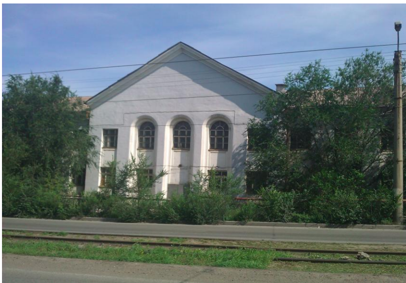
Здание АСУП (южная сторона)
